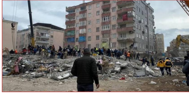
Şekil 5. Yoldaş Apt. deprem sonrası durumu [5]
