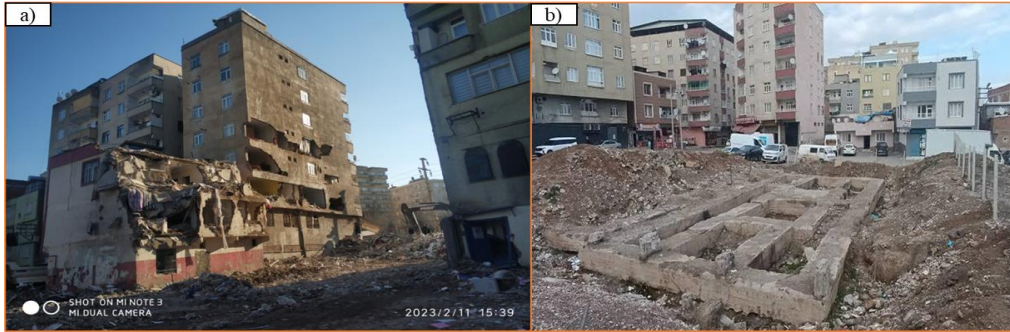
Şekil 4. Dünder Apt. a) deprem sonrası durumu b) yapının mütemadi temel durumu [5]
