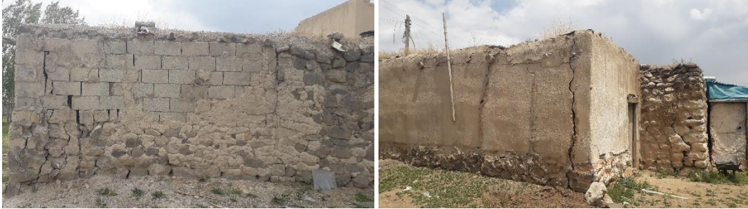
Şekil 4. Temel hareketi sebebi ile gözlenen hasarlar
