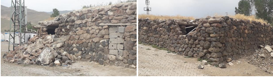
Şekil 7. Duvarlarda gözlenen köşe hasarları
