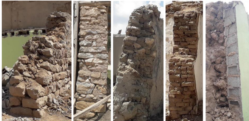
Şekil 2. Köylerde gözlenen duvar kesitleri
