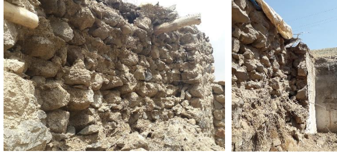
Şekil 8. Duvar dış cidarında gözlenen hasarlar
