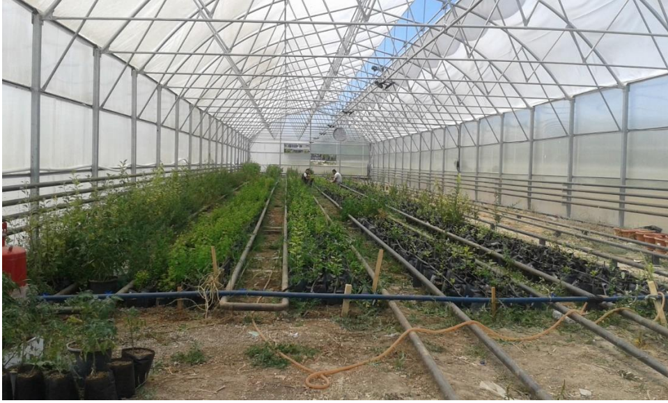
Şekil 2: Doğal gaz ile ısıtılan seranın görüntüsü [6].
